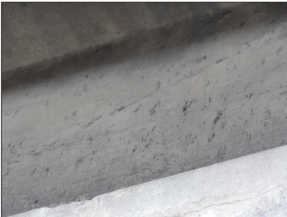
Obr. 7 Šikmá trhlina ve stěně – pravá strana konstrukce, ve vzdálenosti asi 1/4 rozpětí od O 02
