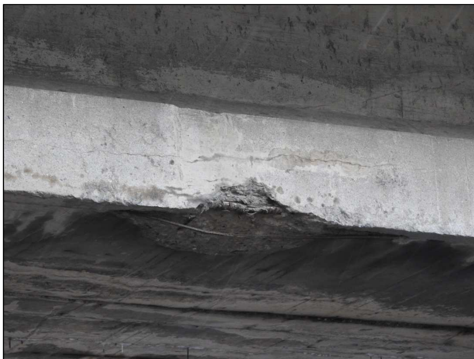
Obr. 15 Odhalený kabelový kanálek i předpínací výztuž – pravá strana konstrukce, ve vzdálenosti asi 1/4 rozpětí od O 02
