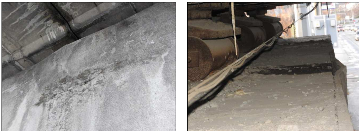
Obr. 24a (vlevo) a 24b (vpravo) Vyboulená omítka v čelní ploše opěry O 01
