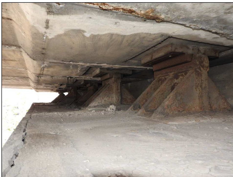
Obr. 20 Pevná ložiska na opěře O 01 – pohled zleva
