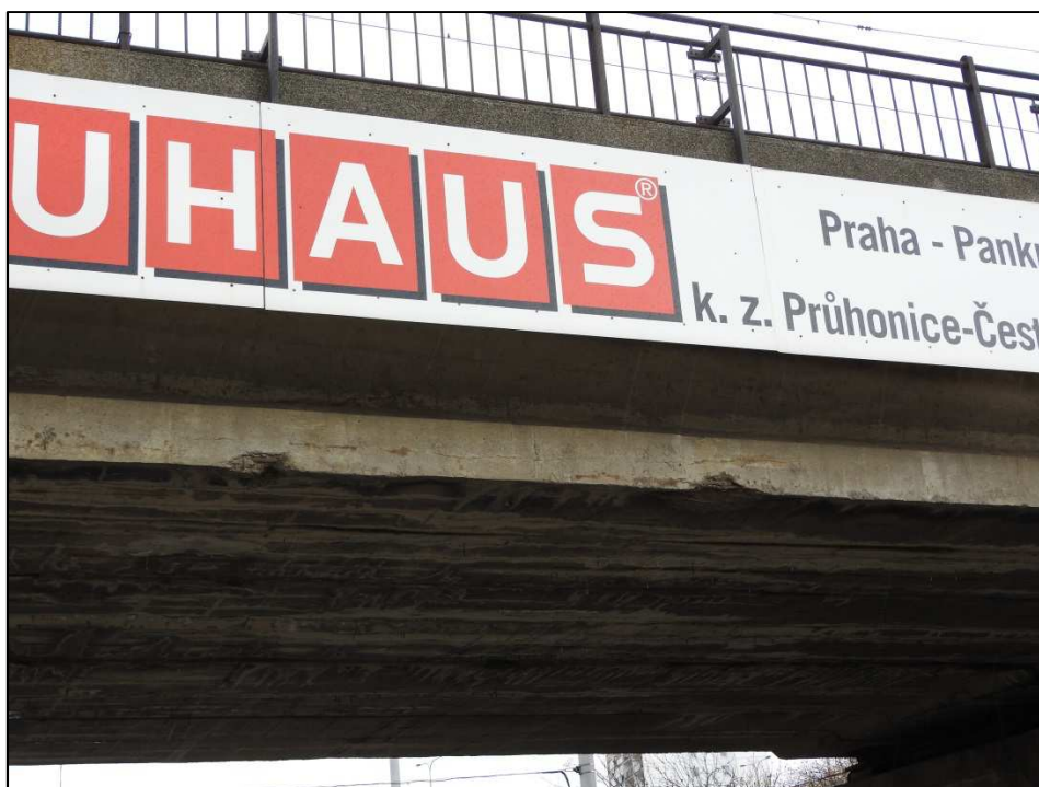
Obr. 13 Odhalené kanálky předpínací výztuže – pravá strana nosné konstrukce ve vzdálenosti přibližně 1/3 rozpětí a 1/4 rozpětí od opěry O 02
