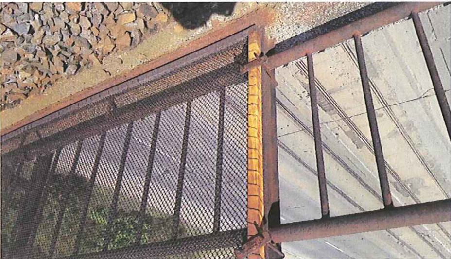
Obr. 9 Korodující přislušenství a protidotykova zábrana na tramvajovou trolej
