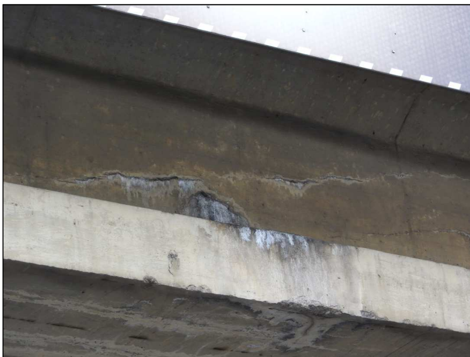
Obr. 5 Šikmé trhliny ve stěně - levá strana nosné konstrukce, ve vzdálenosti asi 1/4 rozpětí od opěry O 01
