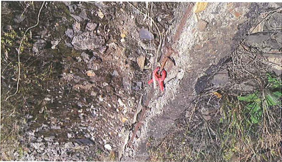
Obr. 12 Měření na obnažené výztuži na NK
