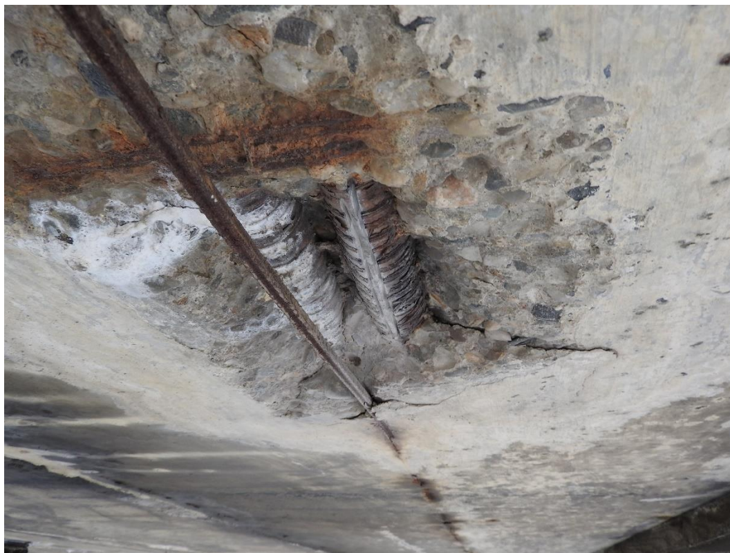
Obr. 10: Odhalená podélná i příčná betonářská výztuž a kanálek pro předpínací výztuž
