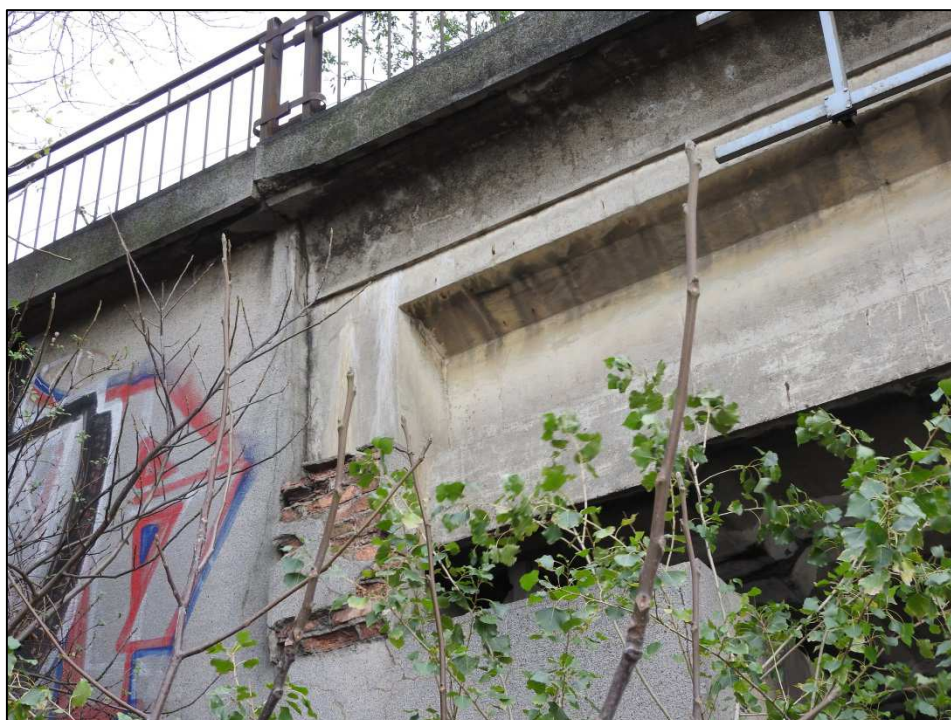
Obr. 18 Pravá strana nosné konstrukce – uložení na opěře O 01
