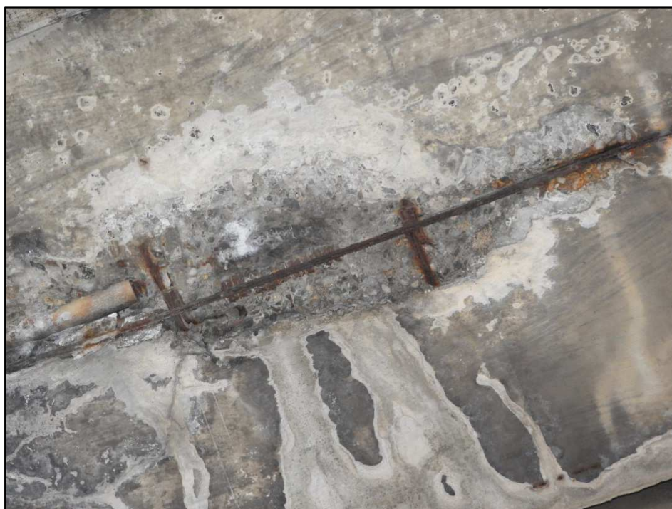
Obr. 12 Odhalené kabelové kanálky (na dvou místech) – levá strana nosné konstrukce, nad tramvajovou tratí přibližně uprostřed rozpětí (vlevo je opěra O 02)
