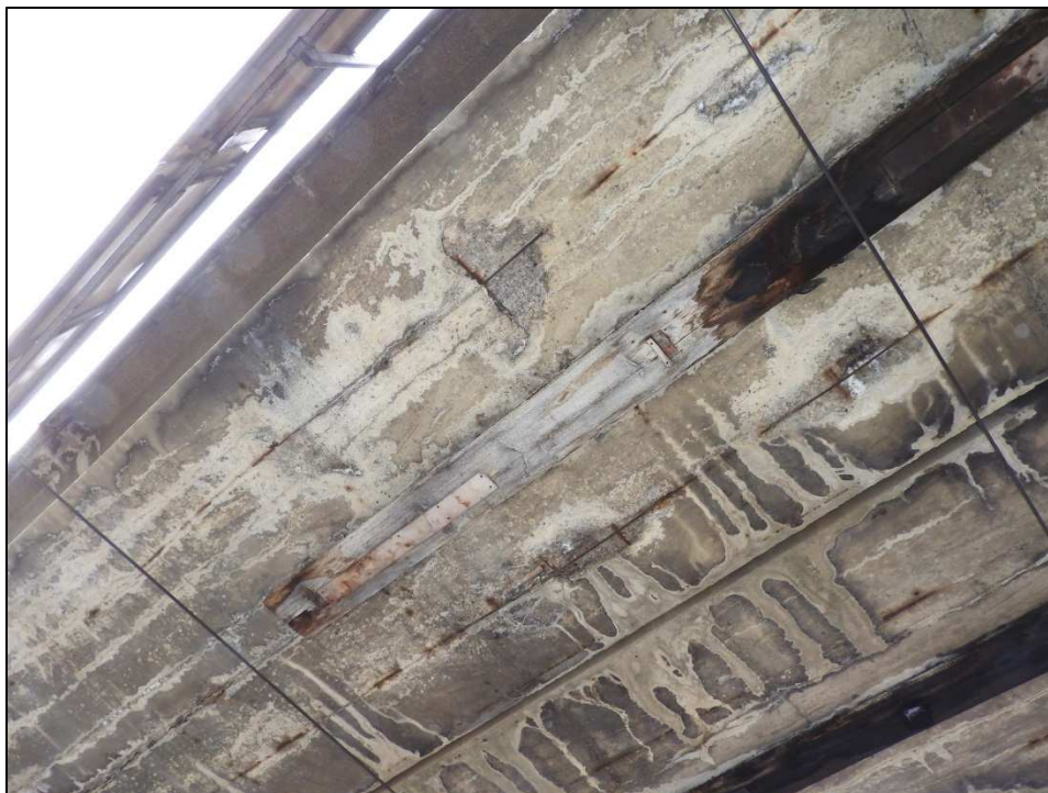
Obr. 11 Odhalené kabelové kanálky (na dvou místech) – levá strana nosné konstrukce, nad tramvajovou tratí přibližně uprostřed rozpětí (vlevo je opěra O 02)
