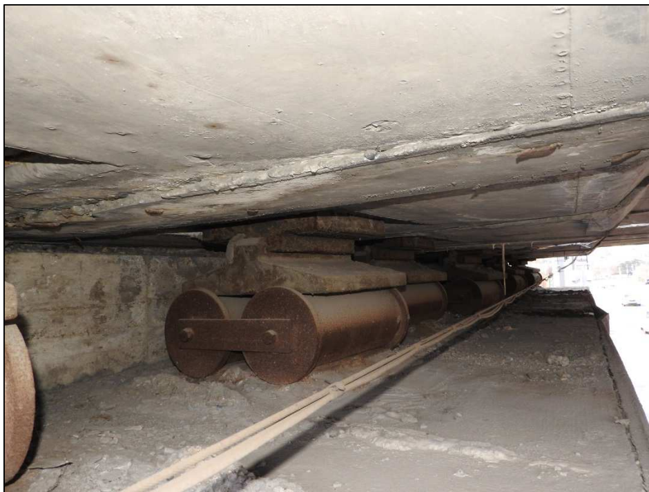
Obr. 21 Válcová ložiska na opěře O 02 – pohled zleva
