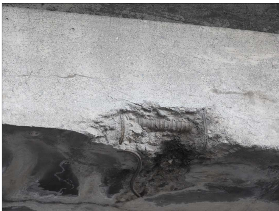
Obr. 14 Odhalený kabelový kanálek – pravá strana nosné konstrukce, přibližně ve vzdálenosti 1/3 rozpětí od O 02
