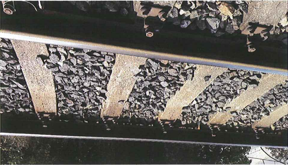
Obr. 9 Korodující přislušenství a protidotykova zábrana na tramvajovou trolej
