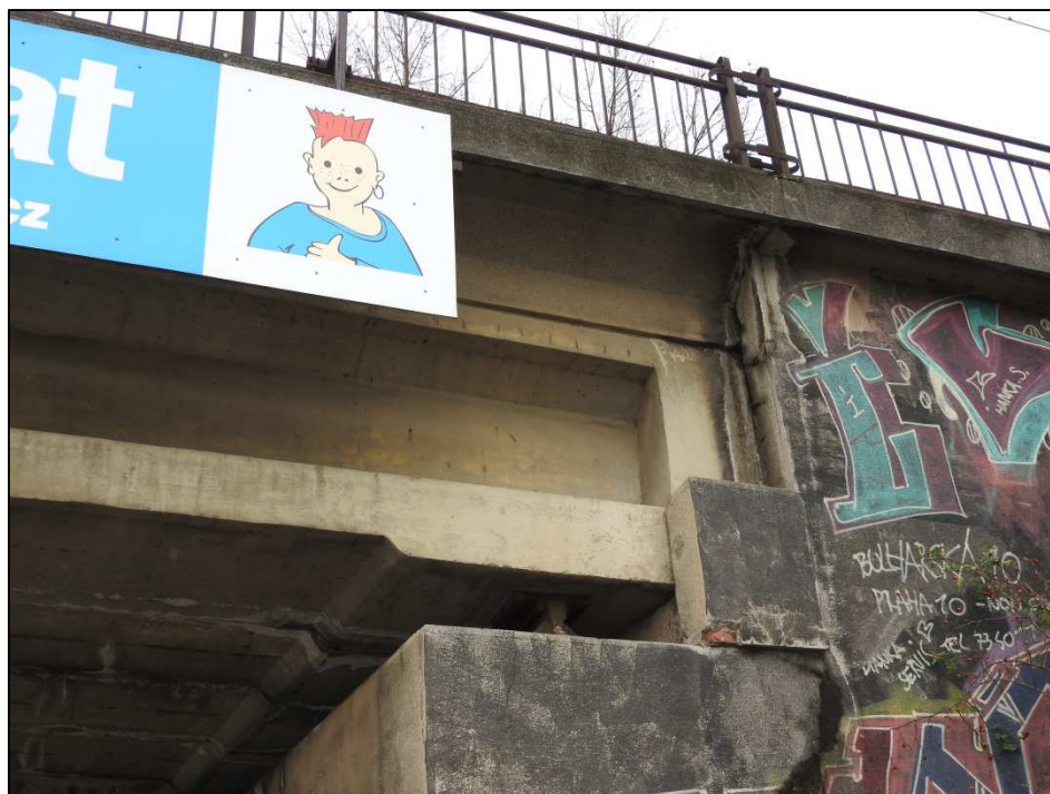
Obr. 17 Levá strana nosné konstrukce – uložení na opěře O 01
