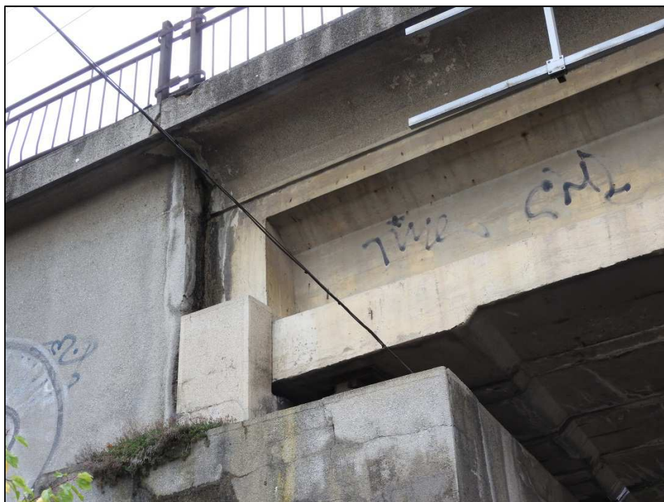
Obr. 16 Levá strana nosné konstrukce – uložení na opěře O 02
